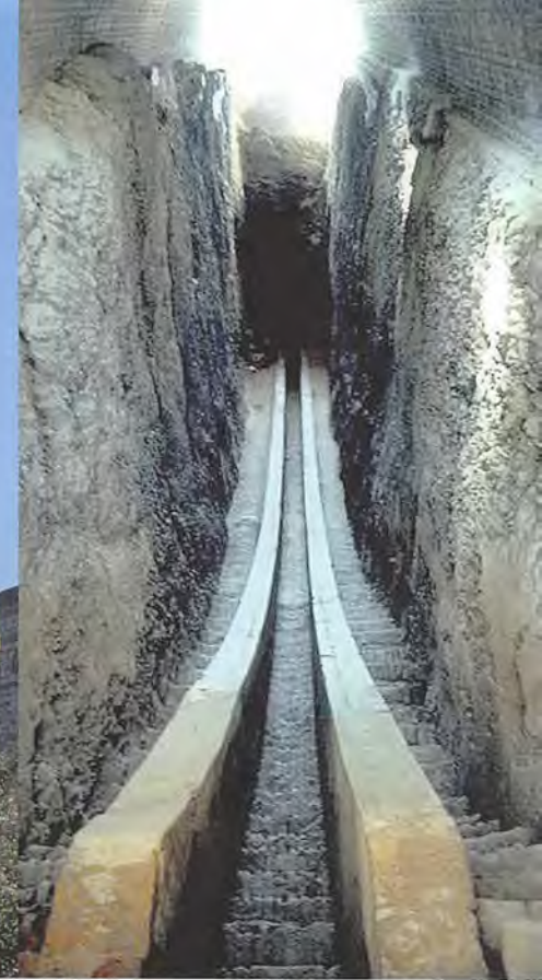
سدسية رخامية عملاقة داخل مرصد أولوغ بيك (Ulugh Beg) إن نصف قطر قوس خط الزوال في هذا المرصد يساوي ارتفاع قبة جامع آيا صوفيا في إسطنبول.
